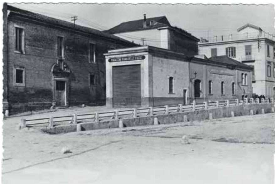
Foggia 1920 – Magazzini piano delle fosse e attiguo ex conservatorio della Maddalena
